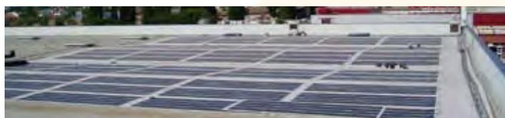
Dies gilt vor allem für die wenig tragfähigen Dächer von Industrieanlagen oder Einkaufszentren. Hier lassen sich gewöhnlich keine herkömmlichen Solarsysteme mit geneigten Modulen mit Glasrahmen montieren, da sie nicht nur durch ihr Eigengewicht sondern auch durch zusätzliche Windlasten die Statik belasten.
