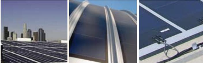
El bajo impacto visual, su fijación directa al material de cubierta junto con la encapsulación sin vidrio hacen a los laminados FV *UNI-SOLAR* inmunes al vandalismo y al robo.
