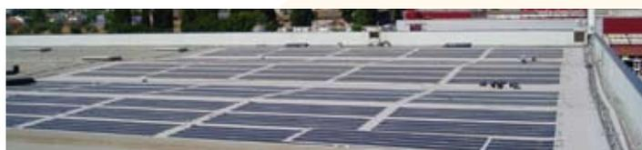
Y esto se aplica en especial a los techados comerciales o industriales con poca carga. Normalmente en estos techados no se pueden equipar sistemas solares convencionales hechos con módulos inclinados con estructura de vidrio que no sólo aportan su peso directo, sino también cargas de viento a la estática.
