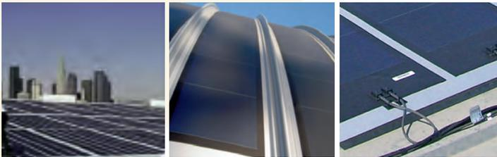
Le faible impact visuel et la fixation directe au matériau de la toiture associée à une encapsulation sans verre protègent les panneaux PV UNI-SOLAR contre le vandalisme ou le vol.
